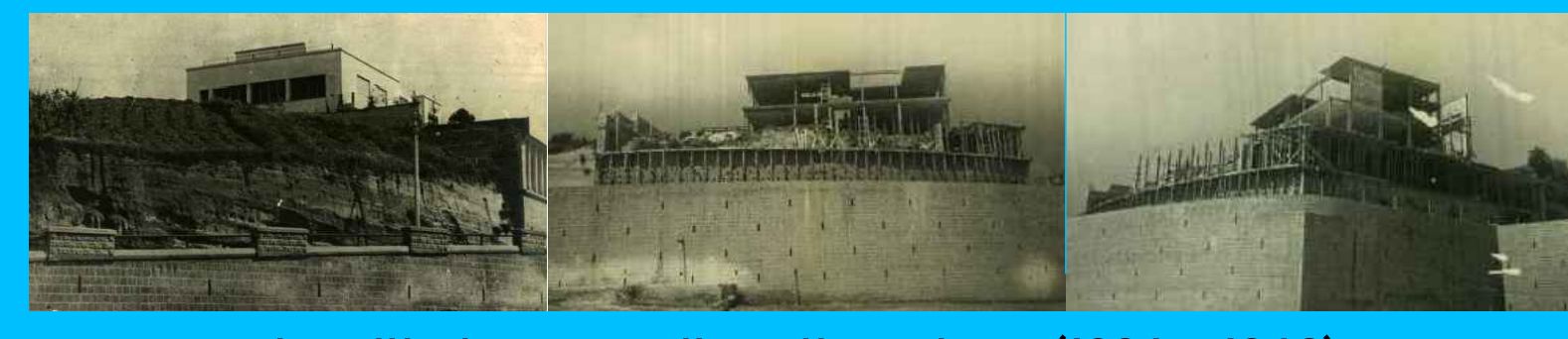
La villa in corso di realizzazione (1936 - 1942)
