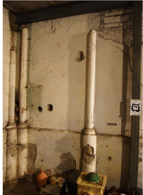
Figura 36: Dettaglio dell'angolo tra la parete in affaccio su via Lucrezia D'Alagno e la facciata di fondo al piano terra (sopralluogo del 29 febbraio 2024).
