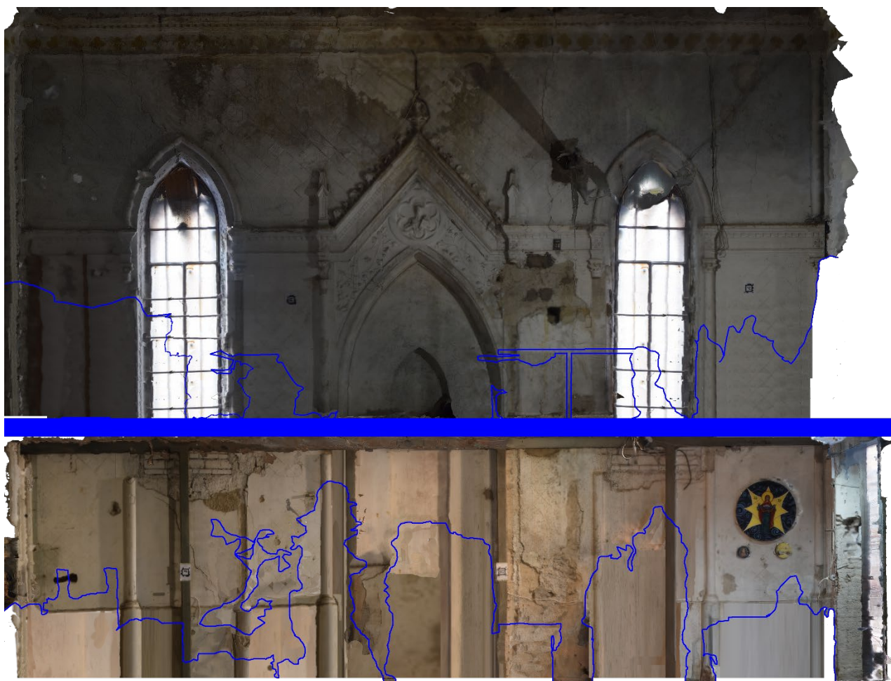
Figura 35: Ricostruzione del fronte tramite ortofoto (29 febbraio 2024). Le integrazioni sono state evidenziate con un contorno in blu (28 maggio 2024).
