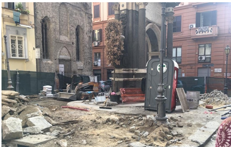
Figura 16: I lavori di ripavimentazione della piazza del 2019, preliminari al restauro della fontana (da Vesuviolive.it).
