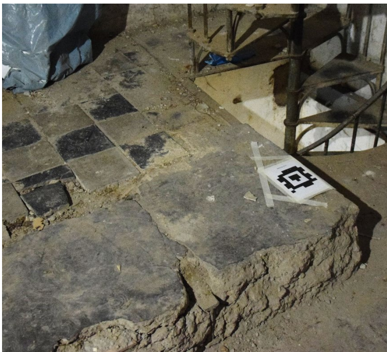
Figura 32: Il solaio del coro visto dall'ambiente di deposito (sopralluogo del 29 febbraio 2024).
