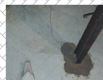
Foto 15 (12.02.2024) Ancoraggio della trave d'argano e lesioni conseguenti
