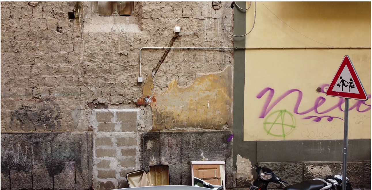
Figura 19: L'apertura ricavata nella bocca di lupo, poi murata (sopralluogo del 29 febbraio 2024).
