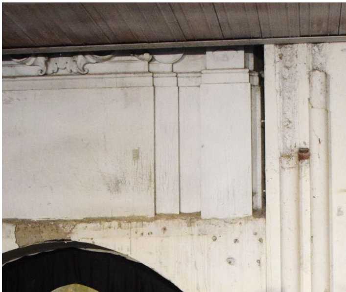
Figura 46: L'arco di scarico e l'altare tinteggiato di bianco (sopralluogo del 29 febbraio 2024).
