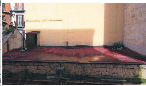
Foto 1 (29.02.2024) Vista del solaio di copertura da via Lucrezia d'Alagno
