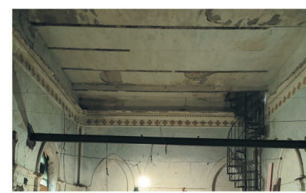
Foto 9 (12.02.2024) Vista della trave d'argano e dell'intradosso della copertura
