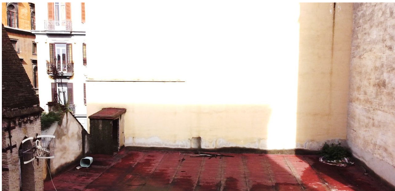
Figura 25: La copertura (sopralluogo del 29 febbraio 2024).
