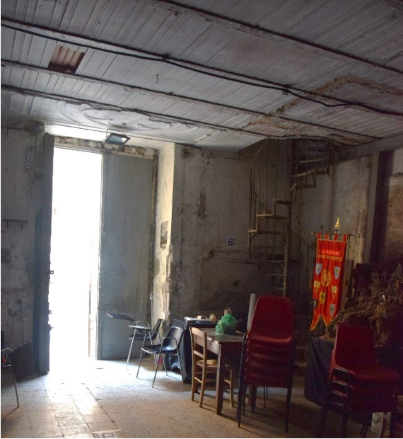
Figura 17: Il solaio abusivo all'intradosso. Si noti il contatto con un solaio preesistente, intonacato e stuccato all'intradosso, realizzato con la medesima tecnologia costruttiva per sostenere il coro della chiesa (sopralluogo del 5 marzo 2024).
