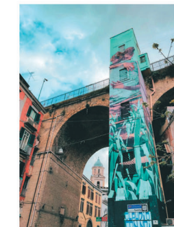
Cabrera - Tieneme ca te fengo Ponte della Sanità
