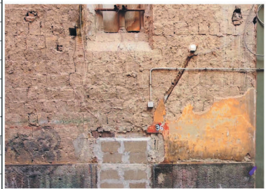
Foto 3 (29.02.2024) Accesso abusivo al locale interrato e bifora "consolidata"
