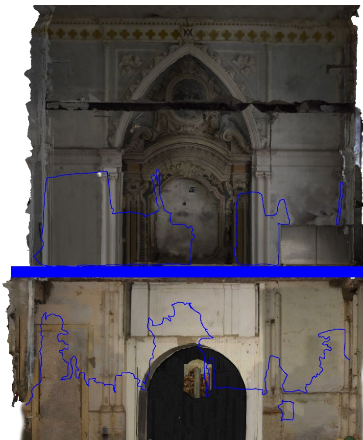
Figura 44: Ricostruzione del fronte tramite ortofoto (29 febbraio 2024). Le integrazioni sono state evidenziate con un contorno in blu (29 maggio 2024).
