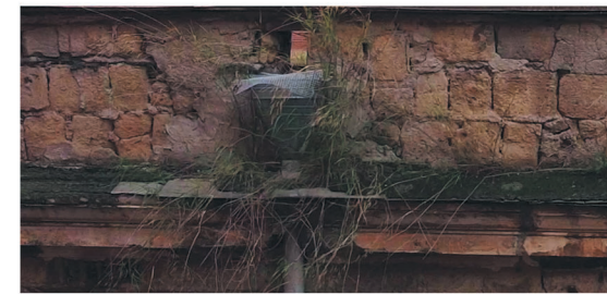
Foto 4 (29.02.2024) Dettaglio del sistema di allontanamento delle acque in copertura
