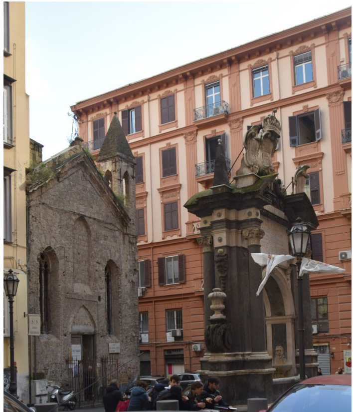
Figura 15: La chiesa allo stato attuale (sopralluogo del 12 febbraio 2024).
