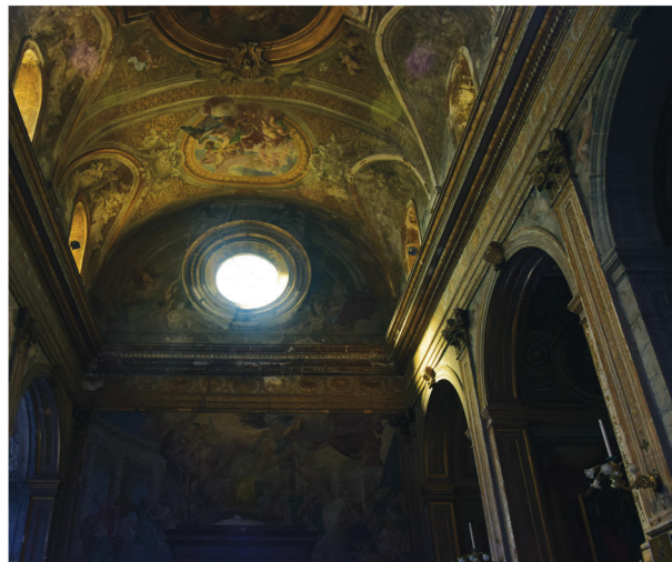
6. Vista della controfacciata, della volta a botte a copertura della navata centrale e delle testate delle volte a botte delle cappelle laterali
