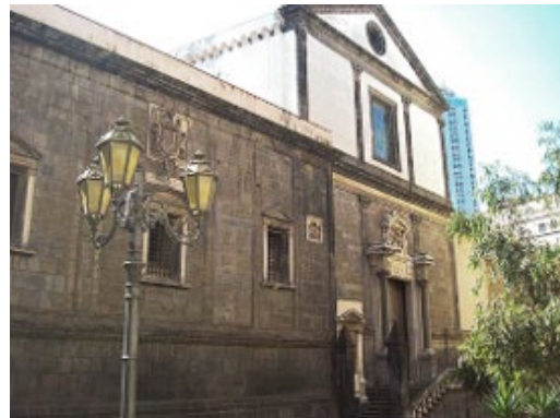
Figura 16: Vista esterna della cappella di San Giacomo della Marca nella Chiesa di Santa Maria la Nova.
