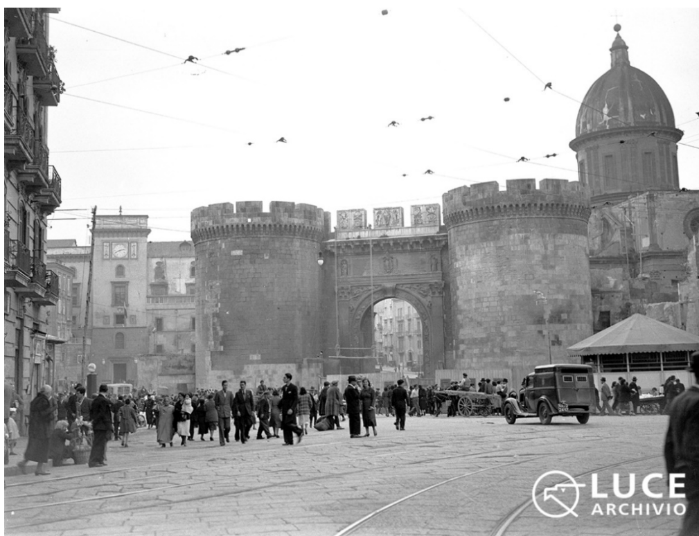
Figura 30: Veduta della facciata esterna di Porta Capuana. Si osservi l'intervento di restauro avvenuto sulla porta negli anni '30 e la rimozione degli edifici addossati ad essa. Archivio fotografico Luce, fondo Amoroso., codice foto FA00004835.
