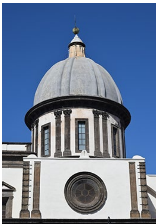
Figura 58: Napoli, la cupola e la testata del transetto (Polidoro, 3 marzo 2024)
