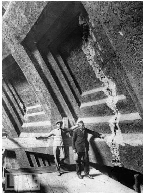
Figura 59: Ispezione del 1925 di lesioni sulla cupola del Pantheon. LIFE magazine, 1925.
